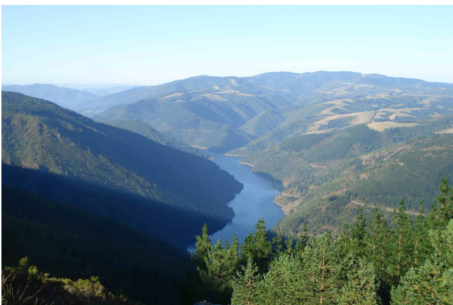
Zicht op het stuwwmeer van Grandas de Salime
